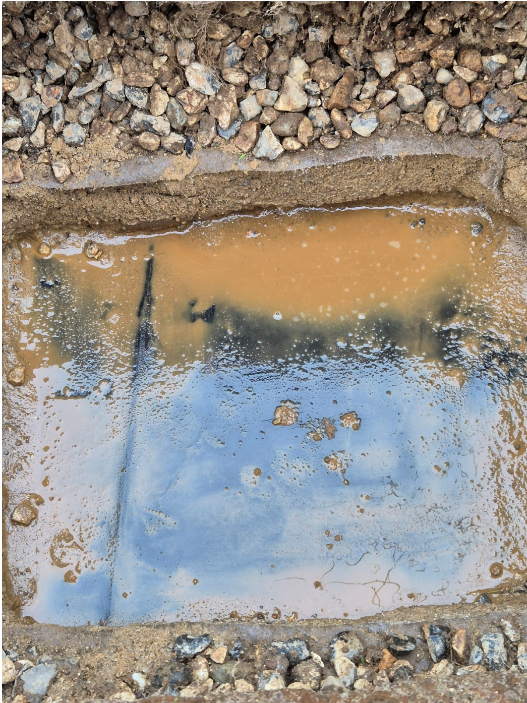
Billede 6 - Billedet viser membranen med en fold eller svejsning. Det er usikkert præcist hvad det er. Folden eller svejsningen viser ingen tegn på nedbrydning og fremstår i samme tilstand som den øvrige del af membranen.
